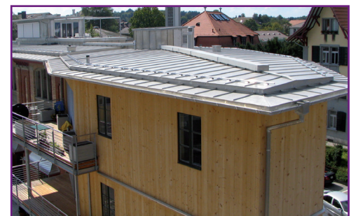
Alte Kohlenhandlung, Langenthal - Suiza. Arquitectos : Blum & Rossenbacher Realizado con la calidad K41 de acabado UGINOX Patina
